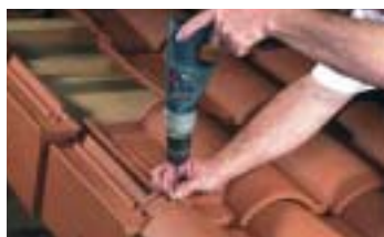
Fixation des 1/2 tuiles en rive latérale gauche par vis et rondelle d'étanchéité.
