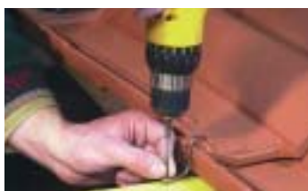
Fixation des tuiles en plain carré pour tenue au vent et à forte pente par crochet "V2" Réf. CRV02.
